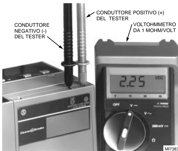
Fig. 22. Misurazione del segnale di fiamma.
