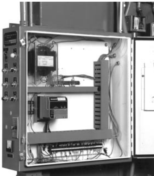
Fig. 7. Installazione nel quadro elettrico.
